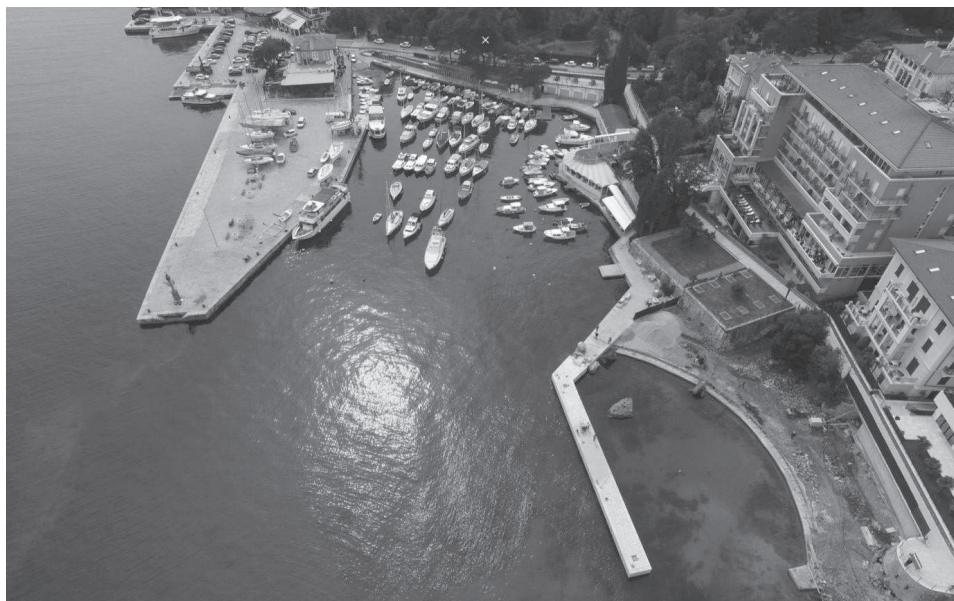
Slika 1. Luka Opatija – pogled na dogradnju luke te završetak radova na „nultoju fazi“ izgradnje 64
