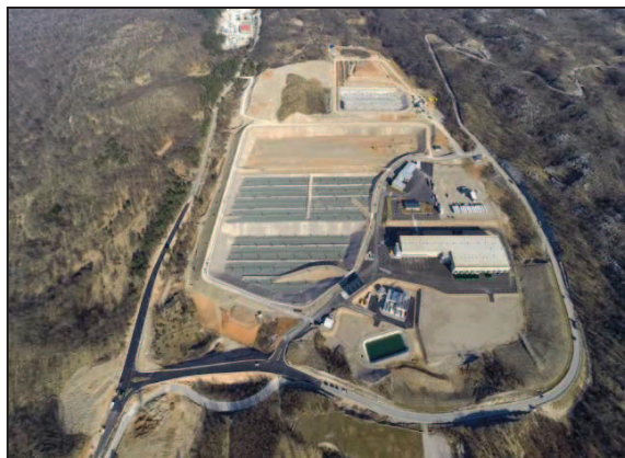
Slika 7. Postrojenje mehaničko biološke obrade u ŽCGO Marišćina (izvor: http://www.ekoplus.hr )
