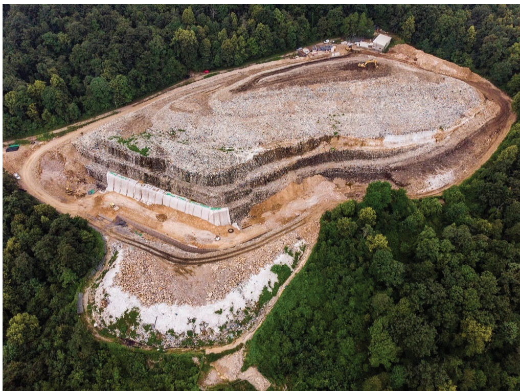
slika 12. radovi na sanaciji odlagališta Osojnica izvor: web Općine Matulji http://www.matulji.hr/
