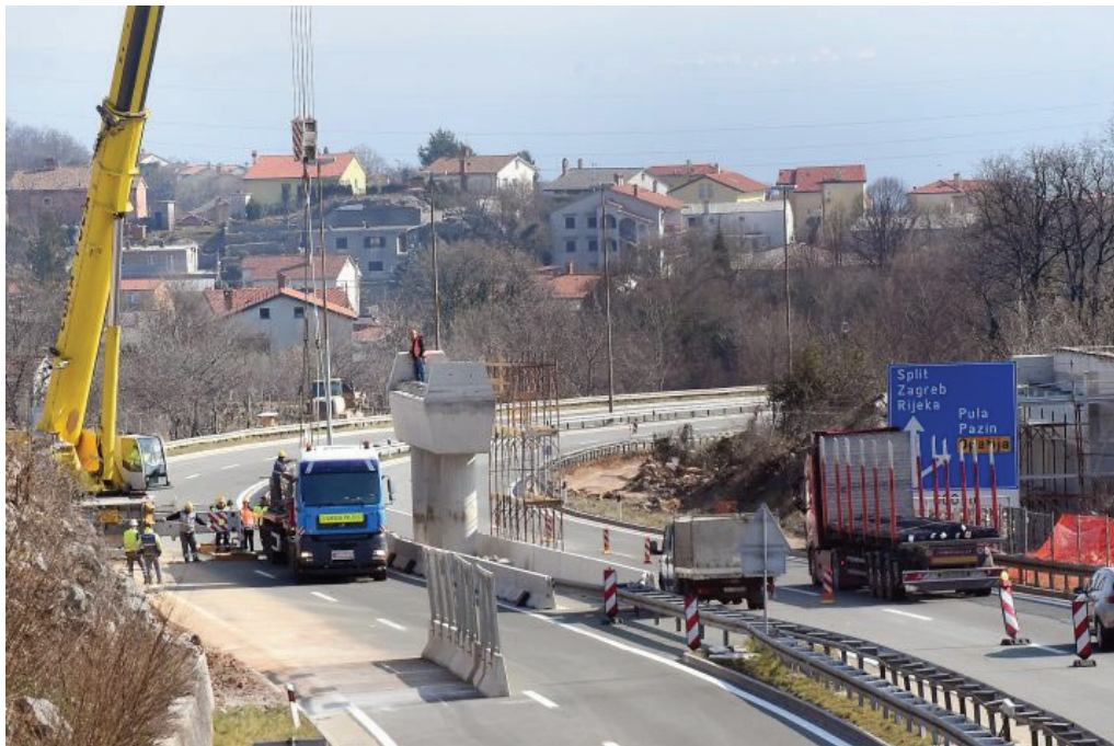
slika 11. radovi na čvoru Trinajstići izvor: web Novog Lista http://www.novolist.hr/
