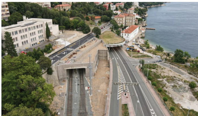
Slika 8. Pogled na novoizgrađeni tunel Sušak
